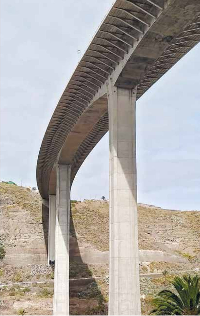
La nueva autovía atraviesa varias montañas y barrancos. Arriba, el viaducto sobre el Barranco de Tenoya, con una longitud total de 528 metros repartidos en cinco vanos, siendo el viaducto más alto construido en el archipiélago canario con una altura que supera los 120 metros.
