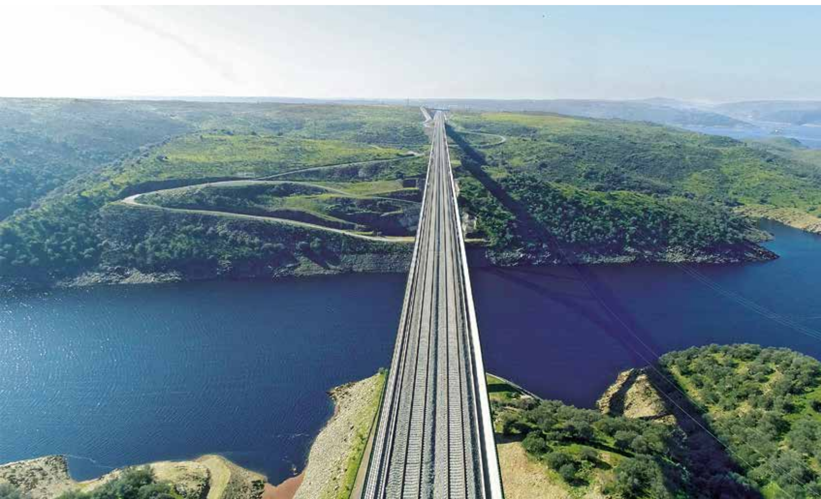
En la nueva línea de alta velocidad Madrid-Extremadura, entre Plasencia y Cáceres, se encuentra el imponente viaducto de Almonte (de 996 m de longitud), que sobrevuela el embalse de Alcántara con un gran arco de hormigón de tablero superior y 384 m de luz principal, lo que le convierte en récord ferroviario del mundo por su luz.
