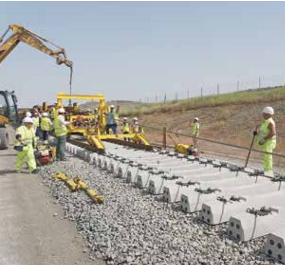
Además del carril suministrado en barras de 270 metros mediante trenes carrileros, se ha suministrado carril en barras de 108 metros sobre plataformas convencionales en composición de dos sextetos, lo que ha requerido desarrollar un nuevo procedimiento de descarga que optimiza el rendimiento de los trabajos.
