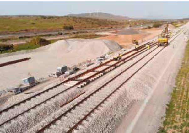
Trabajos de montaje de vía en octubre de 2019 en el tramo entre Plasencia y Cáceres.
