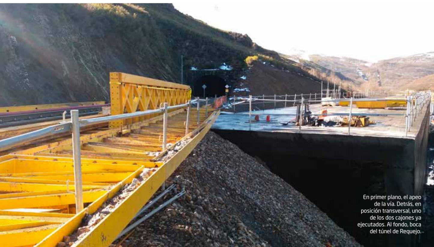
En primer plano, el apeo de la vía. Detrás, en posición transversal, uno de los dos cajones ya ejecutados. Al fondo, boca del túnel de Requejo.
