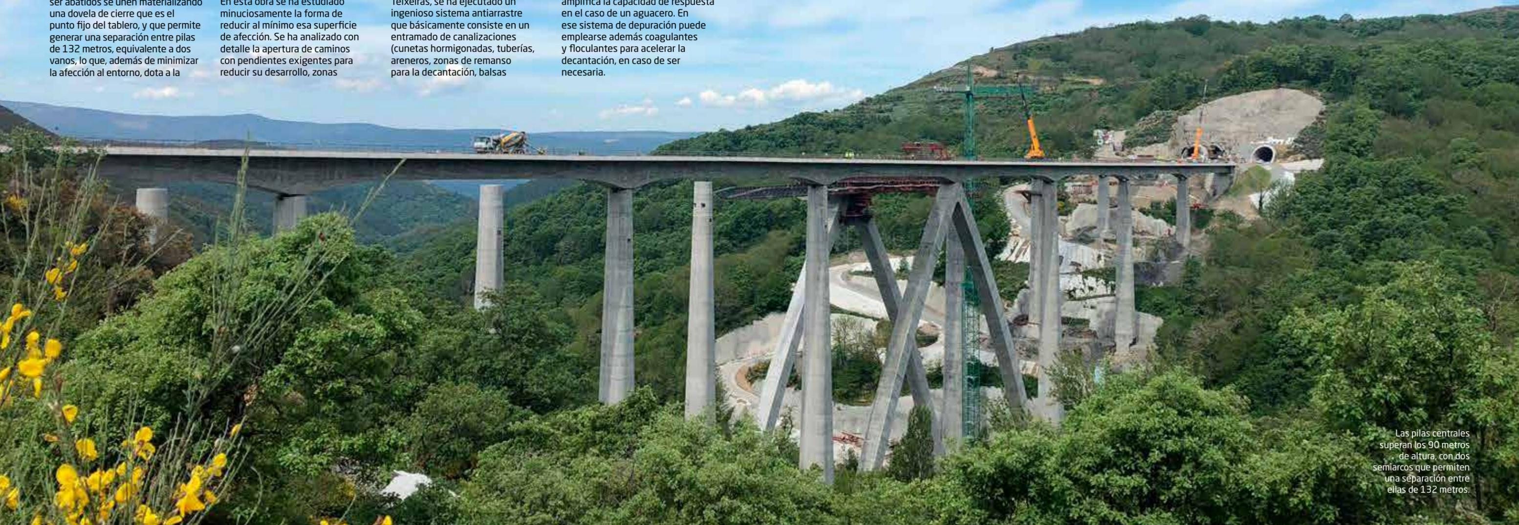
Las pilas centrales superan los 90 metros de altura, con dos semiarcos que permiten una separación entre ellas de 132 metros.
