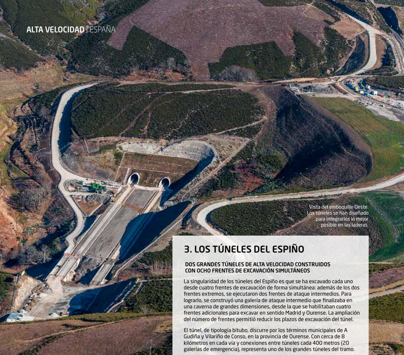
Vista del emboquille Oeste. Los túneles se han diseñado para integrarlos lo mejor posible en las laderas.
