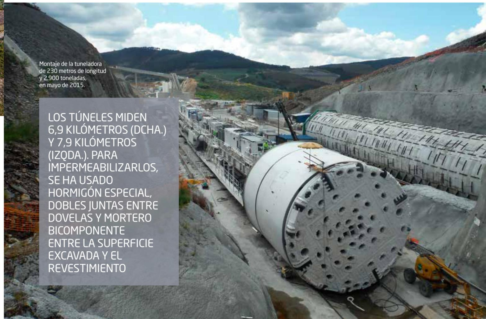
Montaje de la tuneladora de 230 metros de longitud y 2.900 toneladas, en mayo de 2015.
