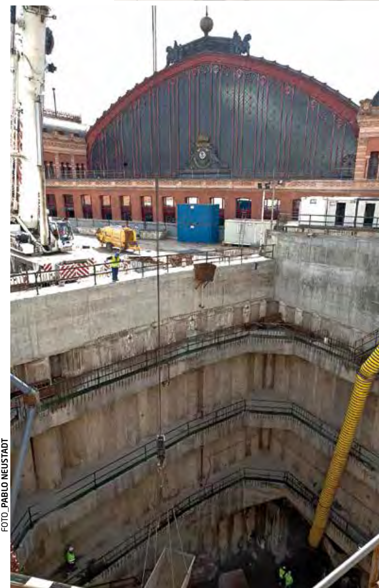
Túnel de alta velocidad entre Atocha y Chamartín, en Madrid, para el que Ineco dirigió las obras y prestó asistencia en auscultación y geotecnia. Arriba: Pozo de emergencia. Centro: Álvaro García Tapia y Juan Martínez trabajando en la señalización en 2017. Abajo: Pozo de extracción de la tuneladora, en Atocha, en 2011.
