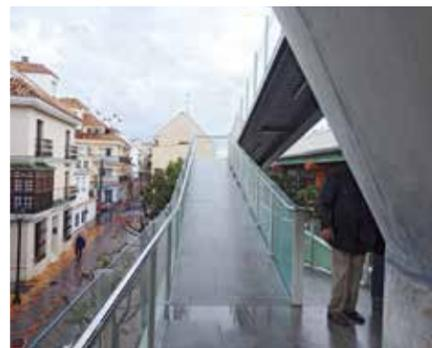
modificación del desarrollo de escaleras y rampas; ampliación de la anchura de la pasarela de acceso a andén; sustitución de pavimentos y barandillas; recricado del andén sobre la cota del plano de vía; adaptación del borde a la normativa de Adif en cuanto a la colocación de baldosas podotáctiles y bandas de señalización; modificación de la marquesina y reforzamiento de su iluminación para el cumplimiento de la normativa actual y sustitución del sistema de alumbrado por led.
