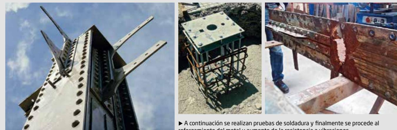
► A continuación se realizan pruebas de soldadura y finalmente se procede al reforzamiento del metal y aumento de la resistencia a vibraciones.
