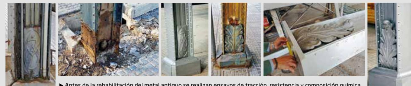
► Antes de la rehabilitación del metal antiguo se realizan ensayos de tracción, resistencia y composición química.
