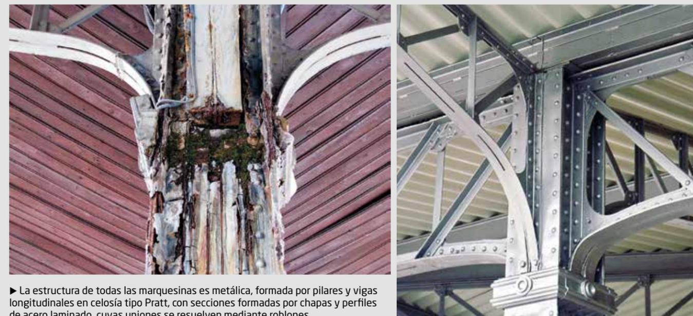
► La estructura de todas las marquesinas es metálica, formada por pilares y vigas longitudinales en celosía tipo Pratt, con secciones formadas por chapas y perfiles de acero laminado, cuyas uniones se resuelven mediante roblones.
