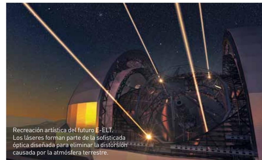
Recreación artística del futuro E-ELT. Los láseres forman parte de la sofisticada óptica diseñada para eliminar la distorsión causada por la atmósfera terrestre.
