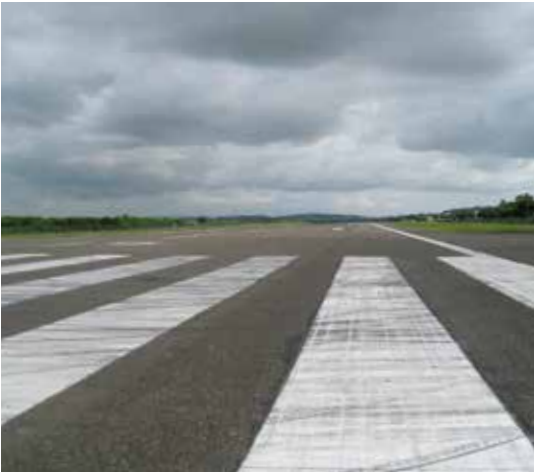
PRINCIPALES ACTUACIONES La repavimentación de las dos plataformas y la pista se han calculado para soportar el aumento de tráfico previsto hasta 2020. También se han mejorado las zonas destinadas a pasajeros.
