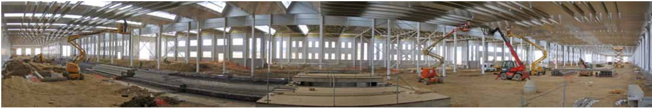
Panorámica de la nave del nuevo taller de reparaciones de Renfe ubicado en Valladolid.
