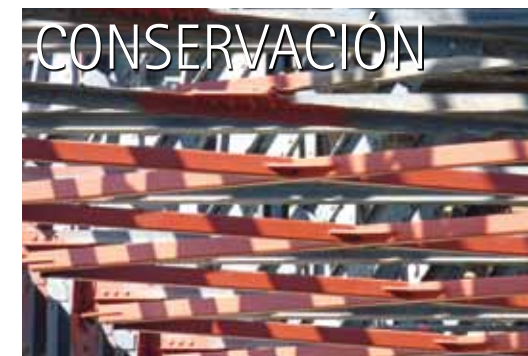
18 Las obras han contemplado varias actuaciones de conservación y de mejora de la estructura.
