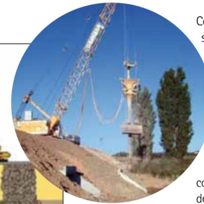
Para ejecutar las perforaciones se introduce un vibrador en el terreno por peso propio, ayudado de aire a presión.
