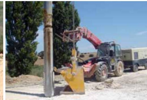
del terraplén ofrecía una buena plataforma de trabajo, amplia y estable para el tránsito de maquinaria pesada, estos aspectos se solucionaron movilizándolo un equipo de vibración que pudiera suspenderse del brazo de una grúa de grandes dimensiones para alcanzar la zona a tratar al pie del talud.
