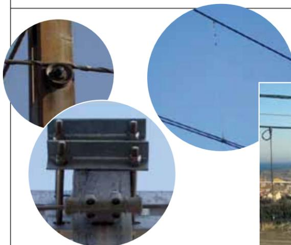
Cambio de grapas para la suspensión del cable de guarda.
