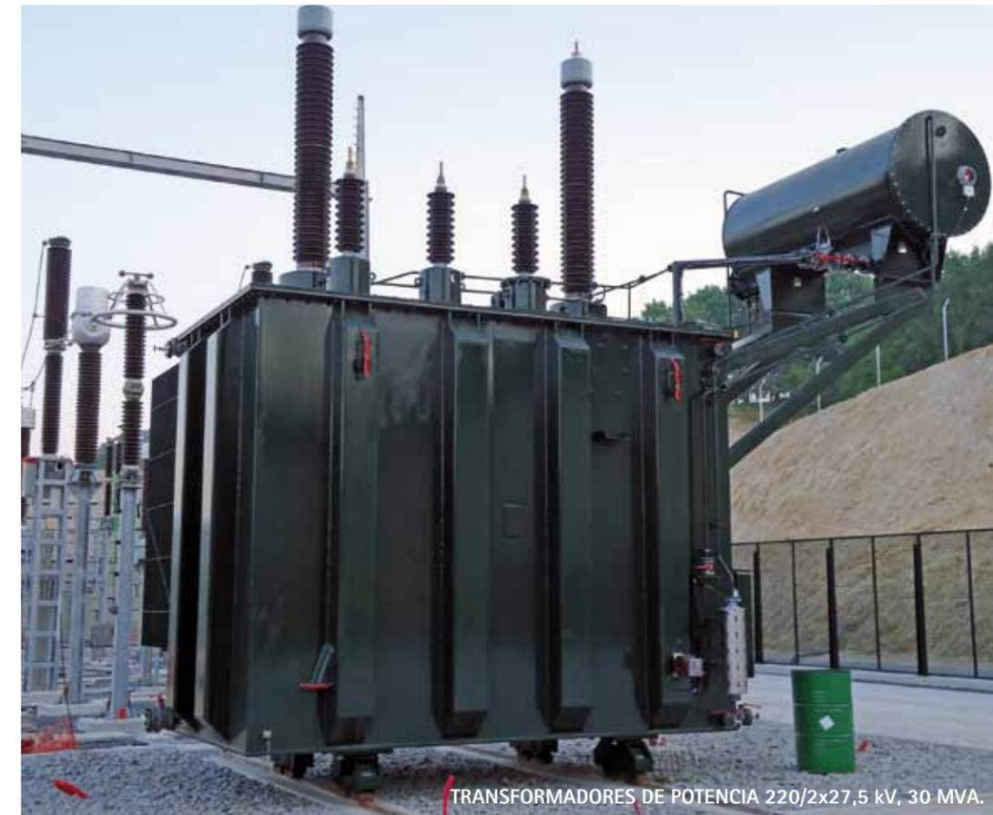
TRANSFORMADORES DE POTENCIA 220/2x27,5 kV, 30 MVA.
