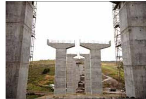
**VIADUCTO V-3.1,** en el Barranquillo de La Dehesa. Consiste en doble tablero a base de vigas prefabricadas de 40 m de longitud.
