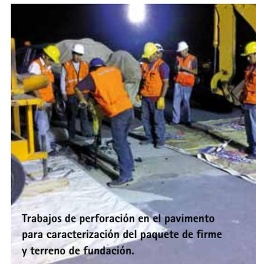
Trabajos de perforación en el pavimento para caracterización del paquete de firme y terreno de fundación.
