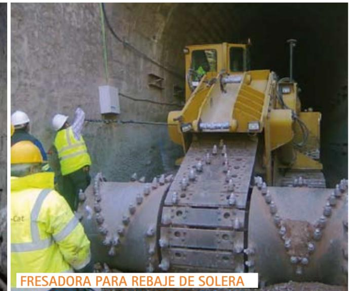
**FRESADORA PARA REBAJE DE SOLERA**
