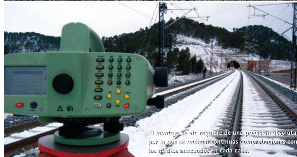
El montaje de vía requiere de una precisión absoluta, por lo que se realizan continuas comprobaciones con los medios adecuados en cada caso.
