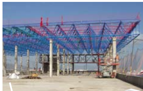
La plataforma de la helisuperficie se sustenta sobre una estructura de malla espacial de 2.400 m 2 aproximadamente, que se ha situado sobre 24 pilares.
