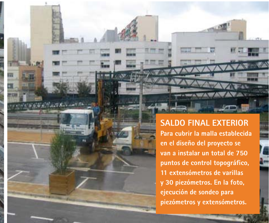
Panorámica general de urbanización ejecutada sobre el túnel.
