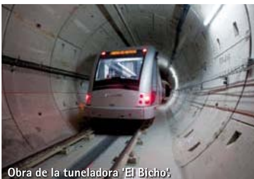
Obra de la tuneladora 'El Bicho'.
