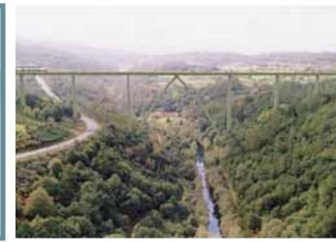
de las magnitudes tensodeformacionales de todos los elementos involucrados. En la imagen se puede apreciar un fotomontaje del futuro viaducto, actualmente en fase de construcción sobre el singular valle del río Deza, sobrevolando con alturas de pila que superan los 100 m. El viaducto se inscribe dentro de una alineación circular en planta de 9.500 m de radio y de pendiente constante -1,4%.
