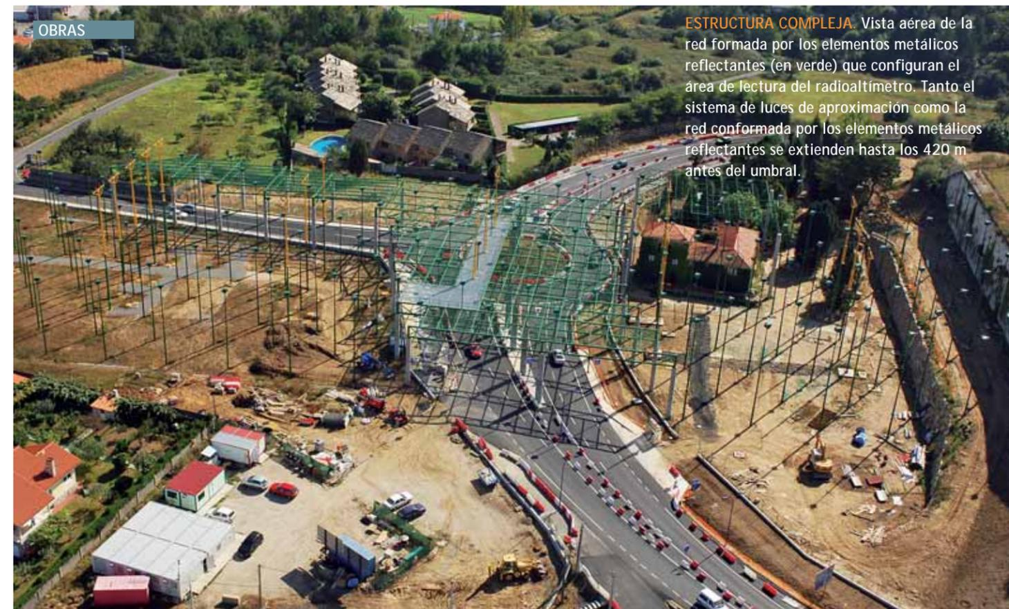
**ESTRUCTURA COMPLEJA.** Vista aérea de la red formada por los elementos metálicos reflectantes (en verde) que configuran el área de lectura del radioaltímetro. Tanto el sistema de luces de aproximación como la red conformada por los elementos metálicos reflectantes se extienden hasta los 420 m antes del umbral.
