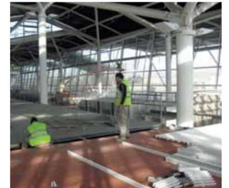
**SOLUCIONES ORIGINALES.** La cubierta descansa sobre soportes principales cada 15 m y bajo ella discurren las instalaciones de drenaje sifónico por presión.
