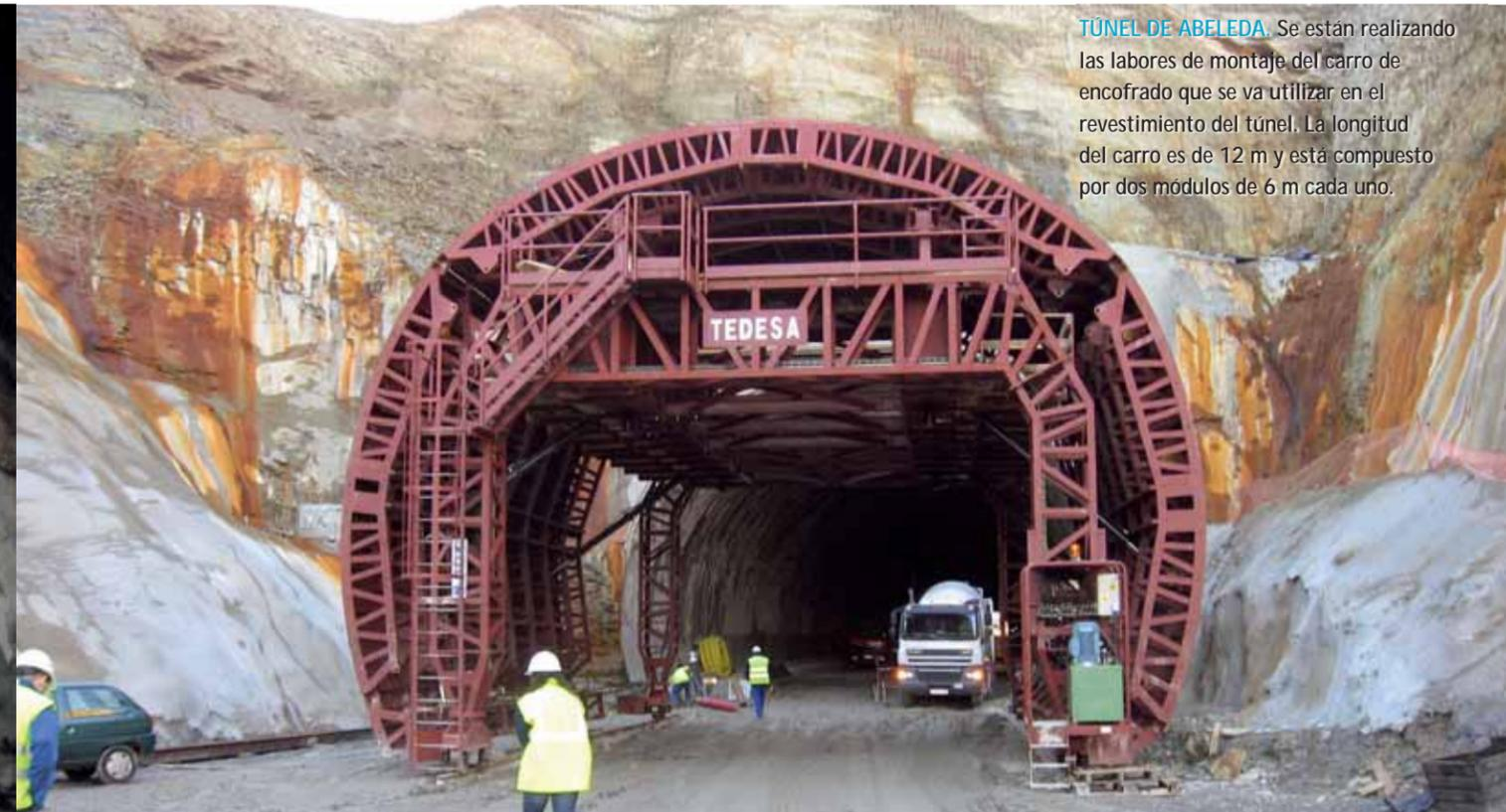
**TÚNEL DE ABELEDA.** Se están realizando las labores de montaje del carro de encofrado que se va utilizar en el revestimiento del túnel. La longitud del carro es de 12 m y está compuesto por dos módulos de 6 m cada uno.
