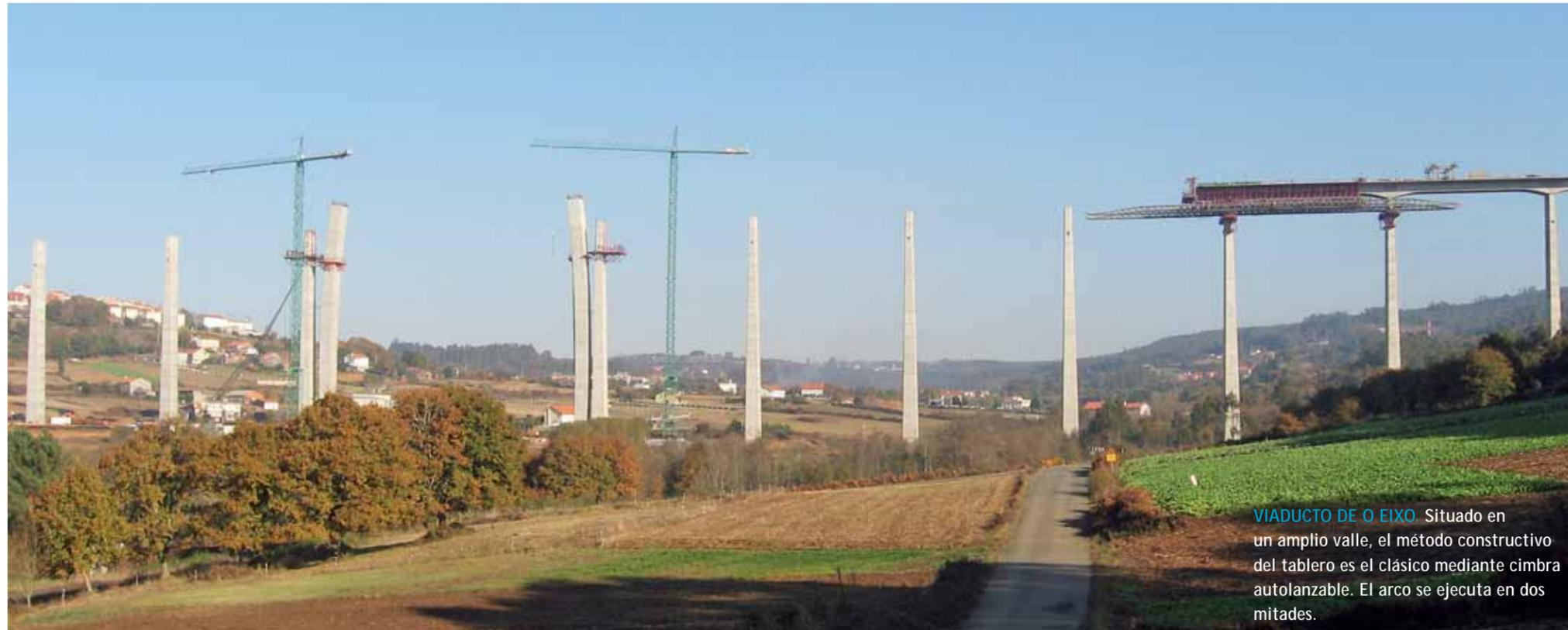
**VIADUCTO DE O EIXO.** Situado en un amplio valle, el método constructivo del tablero es el clásico mediante cimbra autolanzable. El arco se ejecuta en dos mitades.
