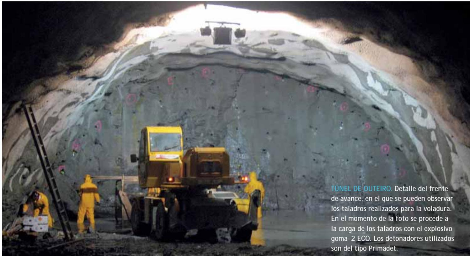
**TÚNEL DE OUTEIRO.** Detalle del frente de avance, en el que se pueden observar los taladros realizados para la voladura. En el momento de la foto se procede a la carga de los taladros con el explosivo goma-2 ECO. Los detonadores utilizados son del tipo Primadet.
