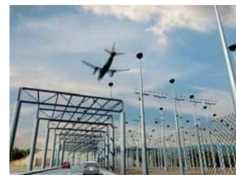
**SUPERFICIE VIRTUAL.** Los elementos reflectantes metálicos conforman una superficie que permite la lectura del radioaltímetro de a bordo sin falsas alarmas.
