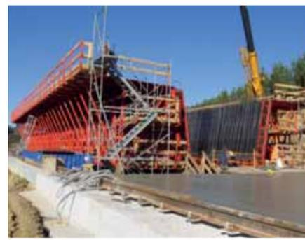
longitud, requiere la construcción de un gran parque de fabricación y empuje que consta de las siguientes zonas: pórtico de ferralla, zona de fabricación de la dovela (en la foto, perteneciente a las actuaciones en Anzo) y zona de deslizamiento. Uno de los viaductos que se levantan en esta región cuenta con una longitud de 752 m, que se distribuye sobre 13 vanos. Se tenderán sobre el nuevo corredor 35 viaductos.
