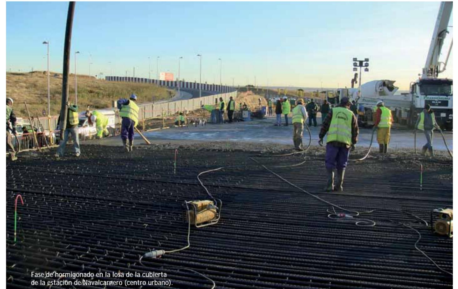
Fase de hormigonado en la losa de la cubierta de la estación de Navacarneiro (centro urbano).
