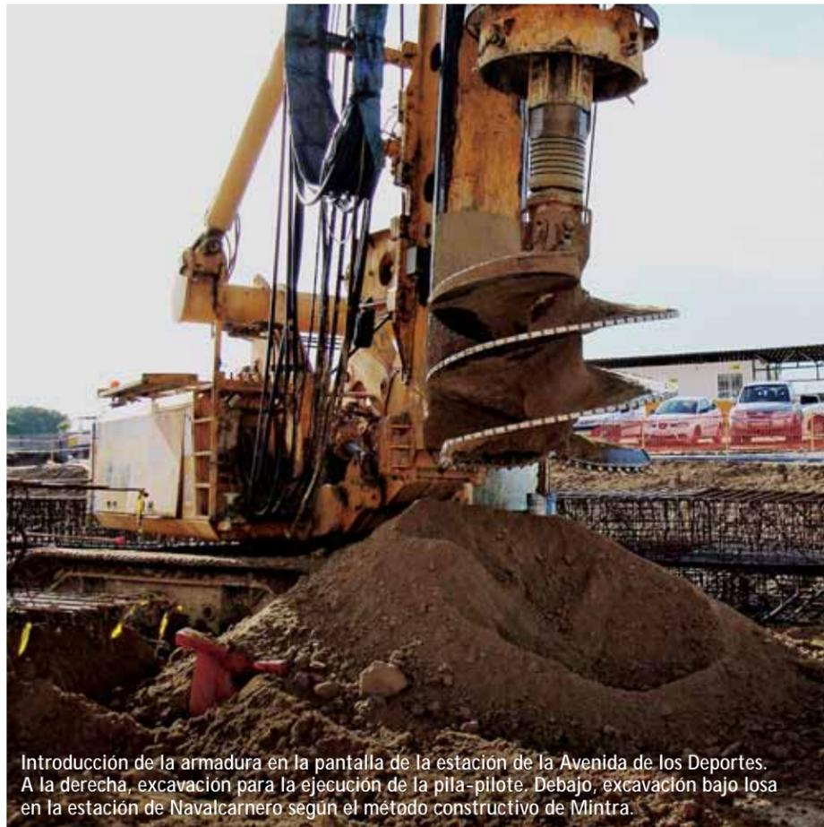
Introducción de la armadura en la pantalla de la estación de la Avenida de los Deportes. A la derecha, excavación para la ejecución de la pila-pilote. Debajo, excavación bajo losa en la estación de Navacarneiro según el método constructivo de Mintra.
