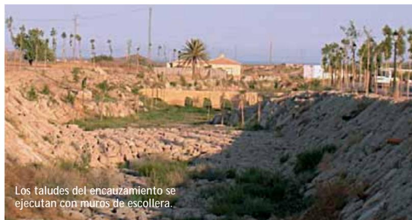
Los taludes del encauzamiento se ejecutan con muros de escollera.
