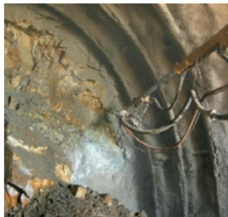
**GUNITADO.** La proyección de hormigón líquido sobre los revestimientos del túnel sirve para asegurar la zona excavada para evitar pequeños desprendimientos y seguir avanzando.
