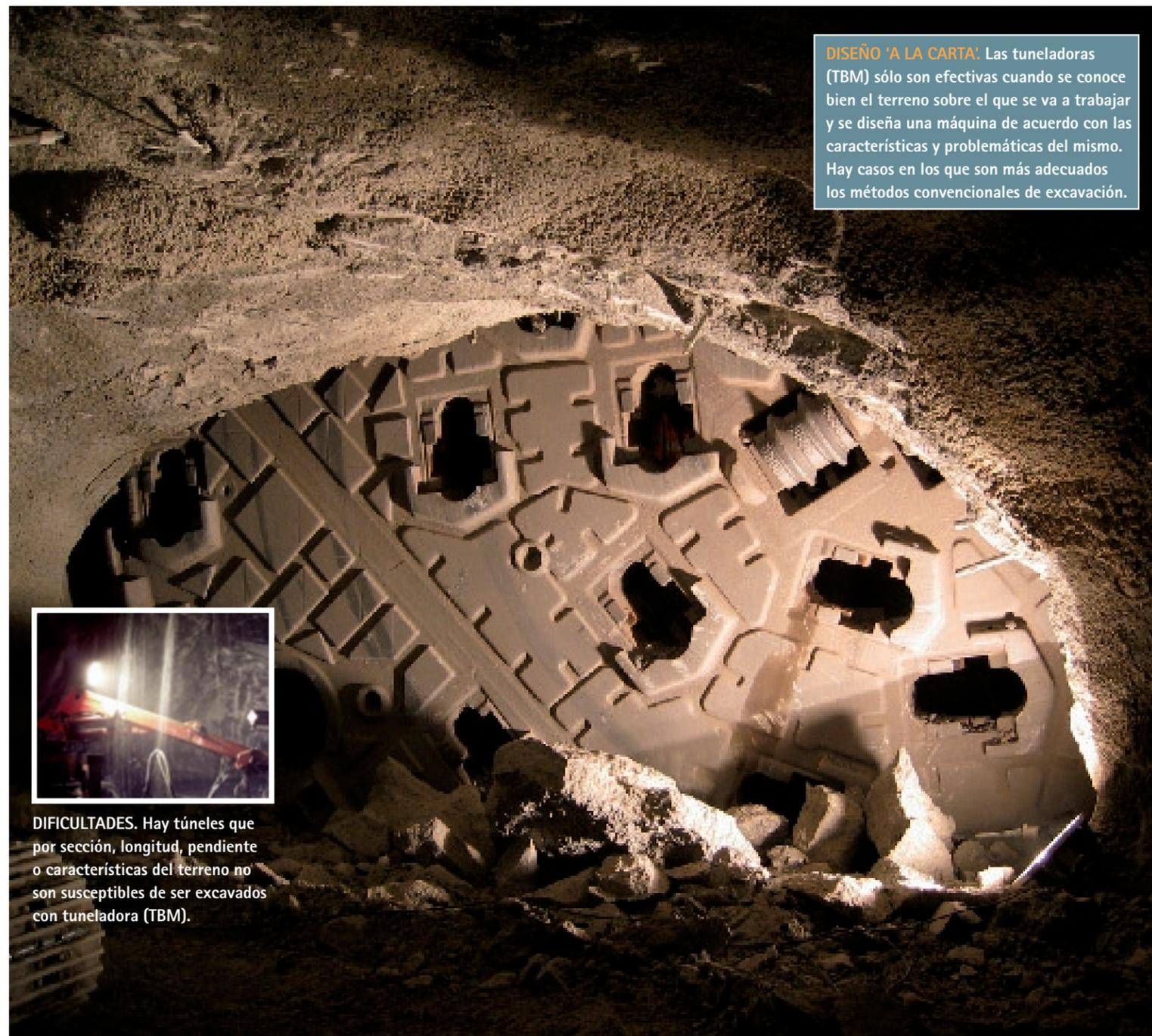
**DISEÑO 'A LA CARTA':** Las tuneladoras (TBM) sólo son efectivas cuando se conoce bien el terreno sobre el que se va a trabajar y se diseña una máquina de acuerdo con las características y problemáticas del mismo. Hay casos en los que son más adecuados los métodos convencionales de excavación.
