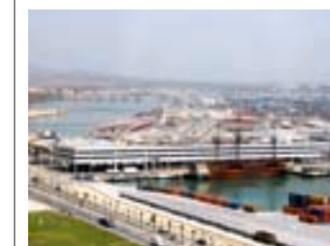
INECO TIFSA ha elaborado para AENA el proyecto de construcción de un helipuerto en el puerto de Algeciras y acometerá en breve la dirección, asistencia técnica de control y vigilancia de dichas obras. Éstas se desarrollan aprovechando el aparcamiento elevado existente, sobre cuya cubierta se construirá un nuevo forjado que sustentará la plataforma del helipuerto. Las obras incluyen la rehabilitación de un edificio próximo propiedad del puerto como Terminal de Pasajeros de dicho Helipuerto.
