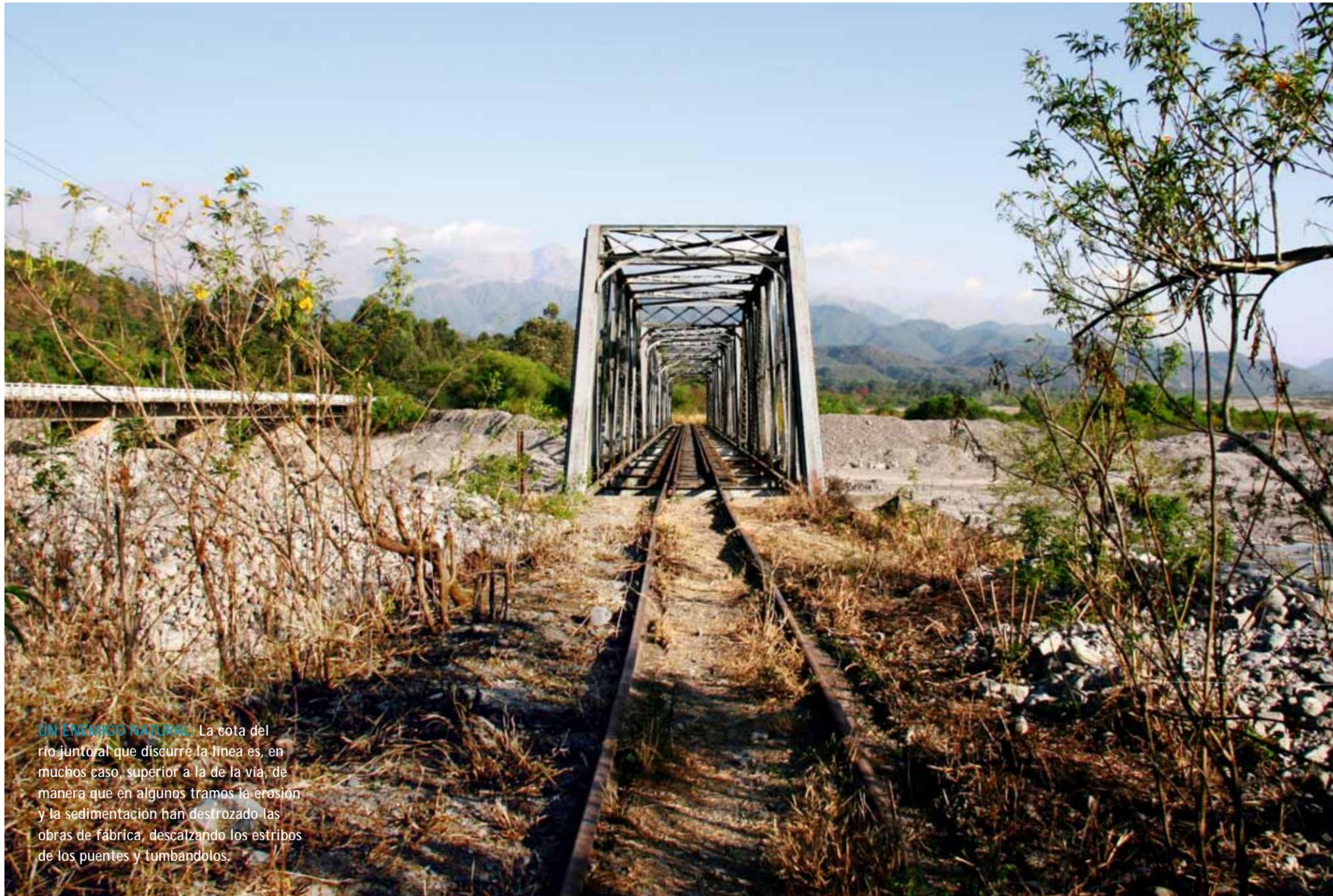
**UN ENEMIGO NATURAL.** La cota del río junto al que discurre la línea es, en muchos casos, superior a la de la vía, de manera que en algunos tramos la erosión y la sedimentación han destrozado las obras de fábrica, descalzando los estribos de los puentes y tumbándolos.
