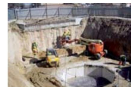
**OBRA MODÉLICA.** Durante las obras se montaron más de 300 sensores de auscultación conectados con el Centro de Control de Obras de Infraestructuras Municipales.
