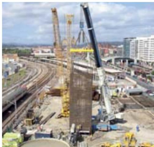
**Pozo de extracción.** Se ha ejecutado un pozo de 14x18 m para permitir la extracción de la máquina.
