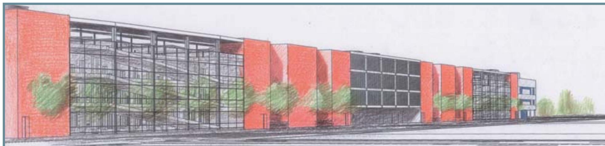
**EDIFICIO P3.** Sobre estas líneas, el aparcamiento P3 que consta de seis niveles, dos de ellos situados bajo rasante. La cubierta del edificio está prevista para el estacionamiento de vehículos, quedando estos
