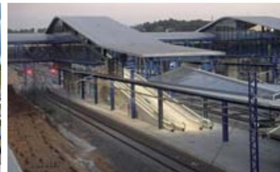
**PASARELA DE ACCESO.** El acceso a los andenes de la estación se realiza desde una pasarela, a través de ascensores y rampas mecánicas cubiertas, que desembarcan a la altura de las cabeceras de los trenes y que se han cubierto con marquesinas en la mitad de su longitud.
