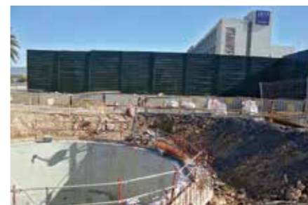
Pantalla acústica provisional instalada para proteger el hotel, situado junto a la salida de emergencia nº 2.
