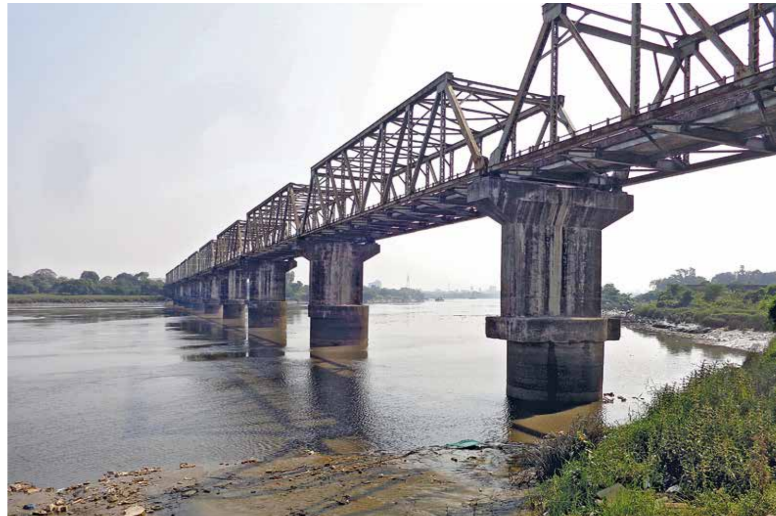
Se ha previsto la construcción de un total de 526 estructuras, necesarias para salvar ríos, líneas ferroviarias y carreteras. En la imagen, viaducto existente del FC sobre el río Ulhas en las cercanías de Thane.
