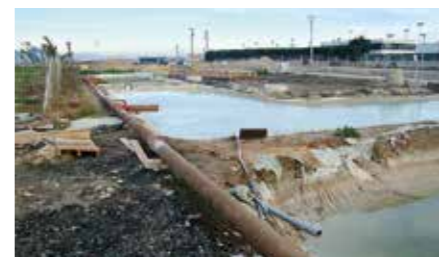
Balsas de agua extraída, reutilizada para el riego de caminos.
