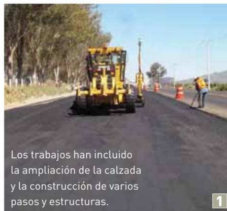
Los trabajos han incluido la ampliación de la calzada y la construcción de varios pasos y estructuras.
