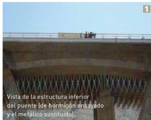
Vista de la estructura inferior del puente (de hormigón ensayado y el metálico sustituido).
