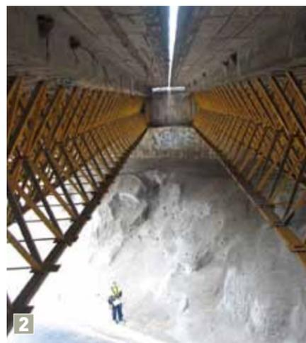
Un inspector examina la estructura metálica unida a la losa superior de hormigón.
