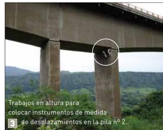
Trabajos en altura para colocar instrumentos de medida de desplazamientos en la pila nº 2.
