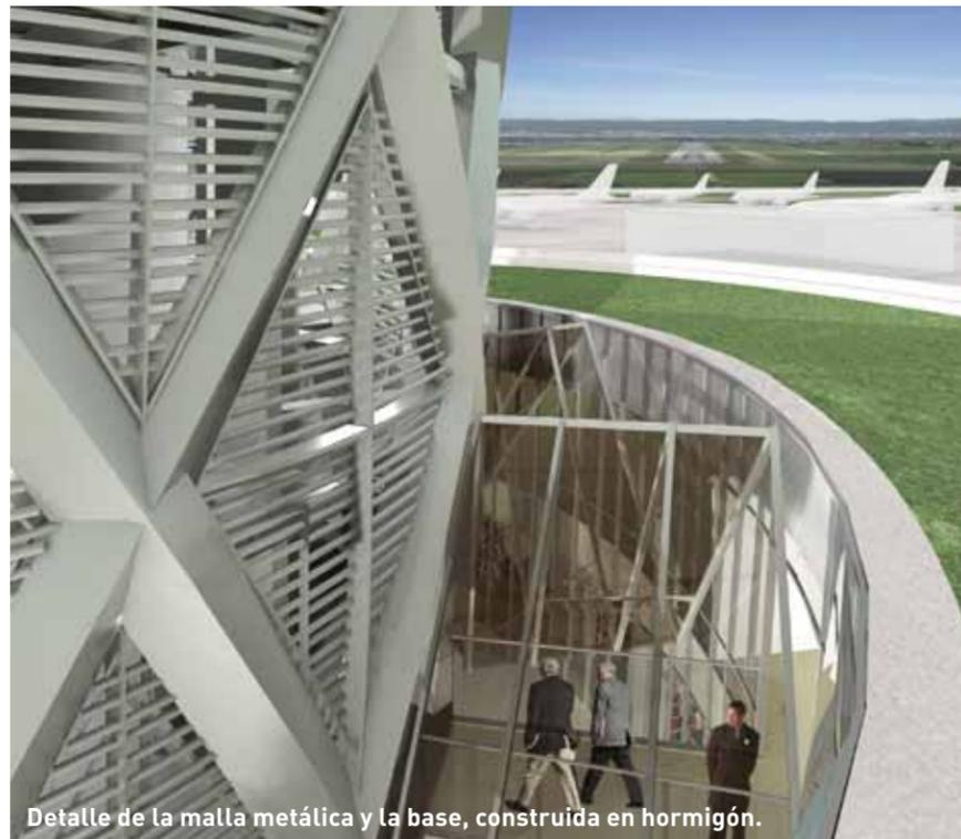
Detalle de la malla metálica y la base, construida en hormigón.
