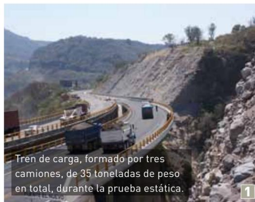
Tren de carga, formado por tres camiones, de 35 toneladas de peso en total, durante la prueba estática.
