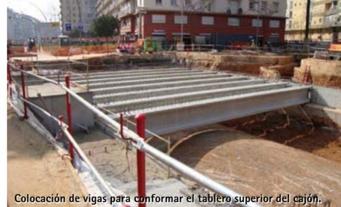
Colocación de vigas para conformar el tablero superior del cajón.
