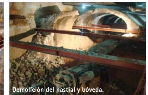
Demolición del hastial y bóveda.
