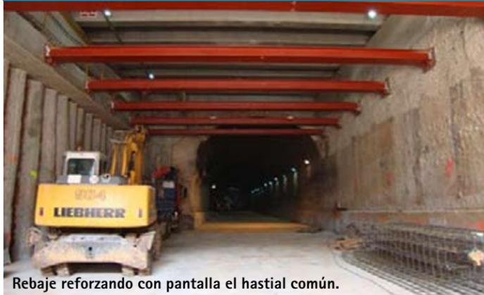
Rebaje reforzando con pantalla el hastial común.
