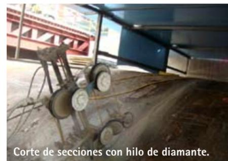
Corte de secciones con hilo de diamante.
