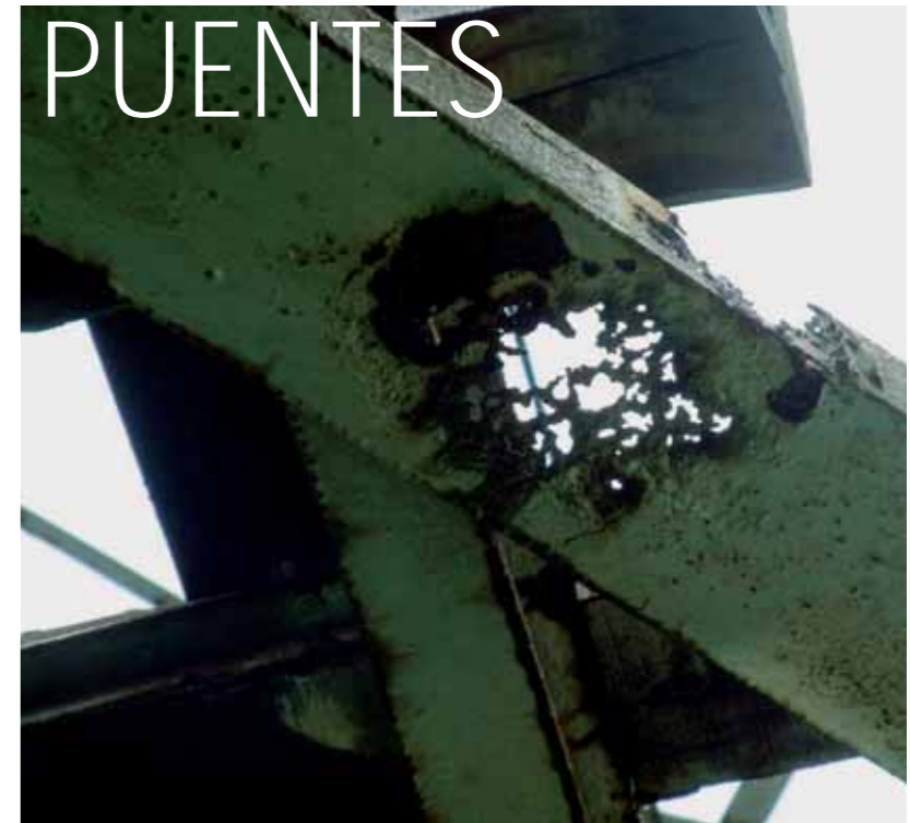
12 La reparación de puentes es una labor en la que se colabora con Adif.
